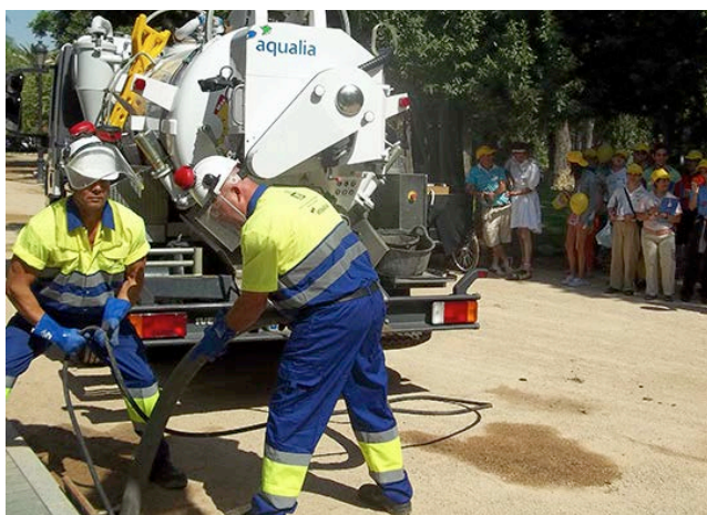
Un momento de la demostración de la limpieza de imbornales.
